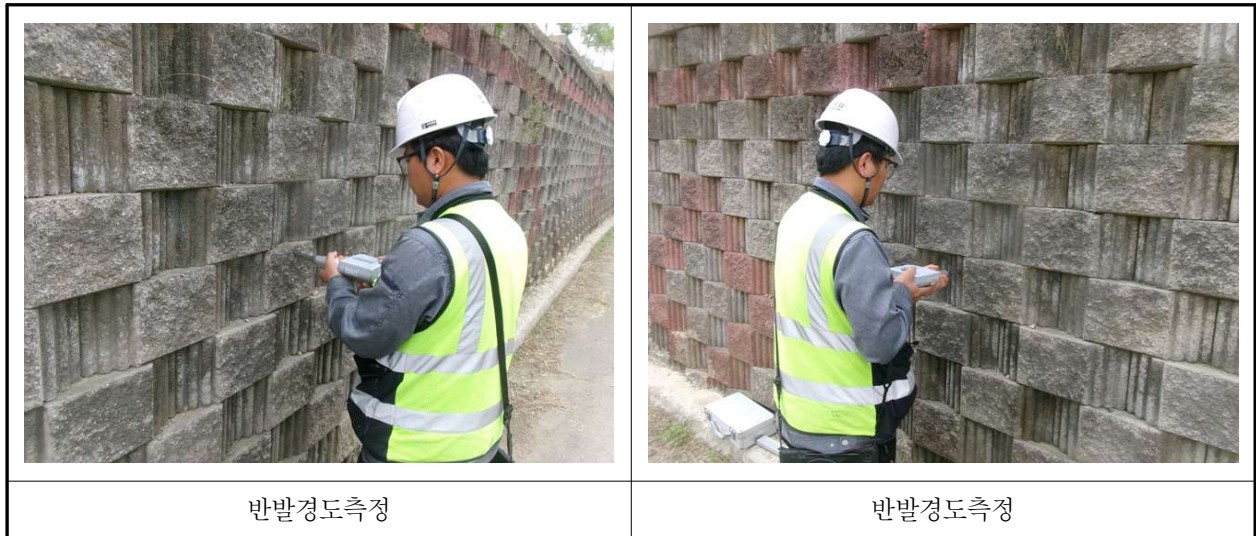
【사진 2.4.1】 재료시험 조사 전경
