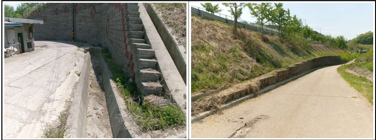
【사진 2.3.1】 지반, 기초부 전경
