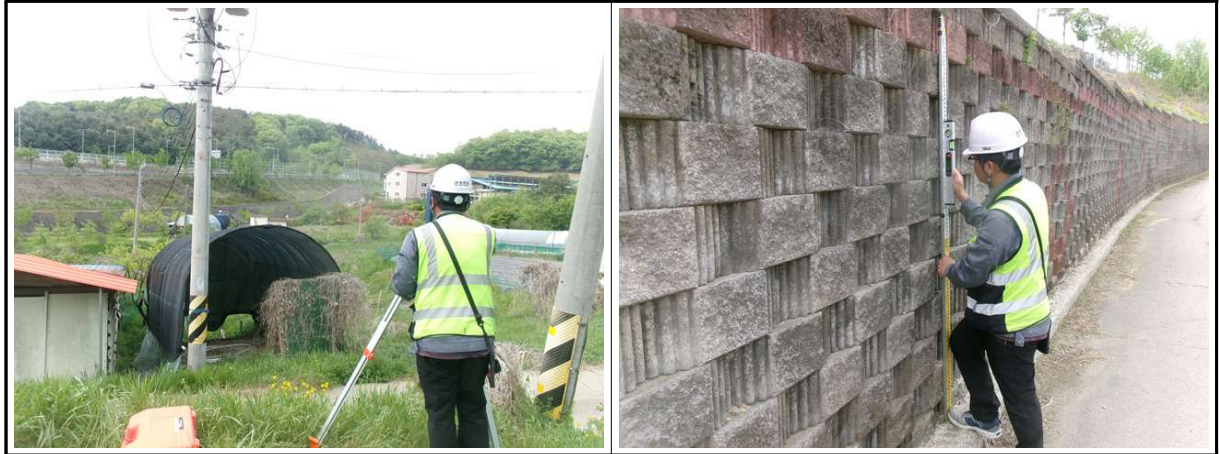
【사진 2.4.2】 측량작업 전경
