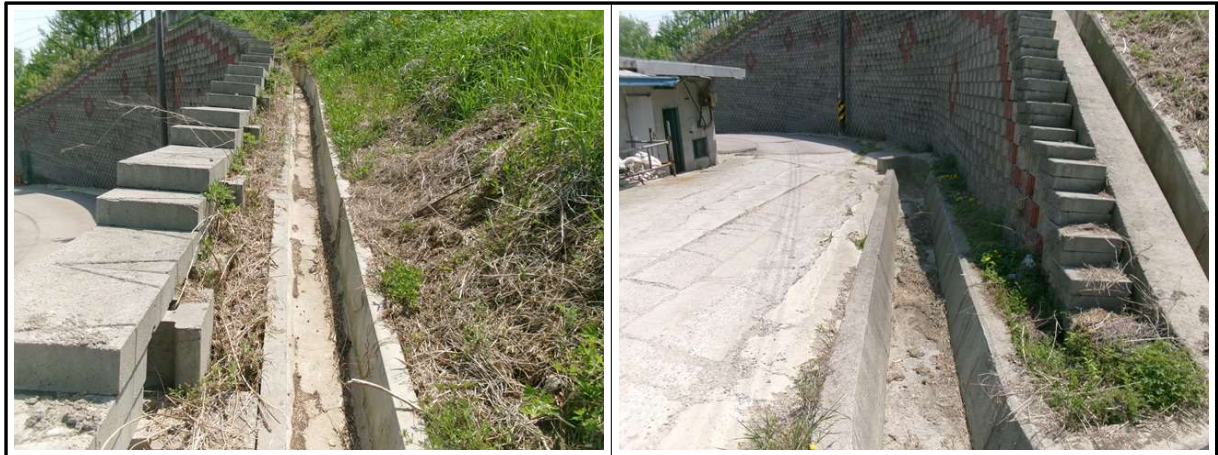
【사진 2.3.3】 배수시설 전경
